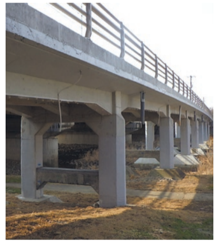
橋梁の修繕が行われた文化橋
