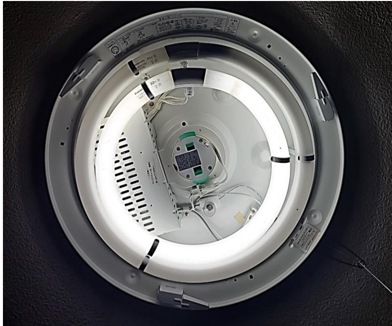
シーリング ライト 交換前
