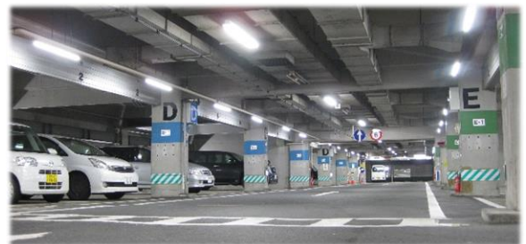
盛岡城跡公園地下駐車場（岩手公園地下駐車場の愛称）
