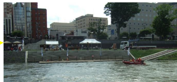
環境整備事業で国で整備した低水護岸(船着き場)
