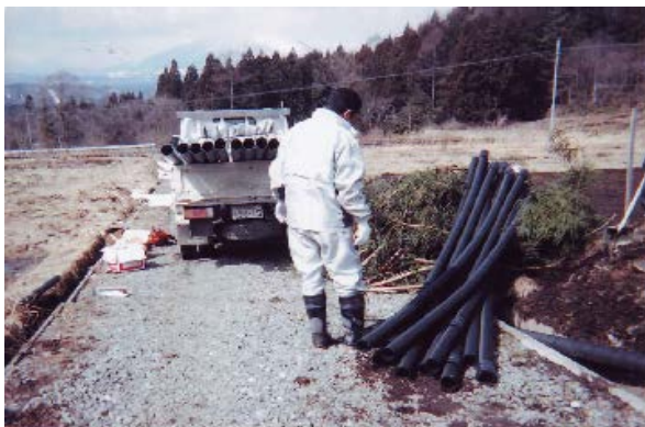
農道補修と水路（パイプ）の整備
