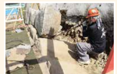
石材をバールで調整する様子
