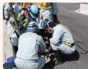
マンホール内の洗浄の様子
