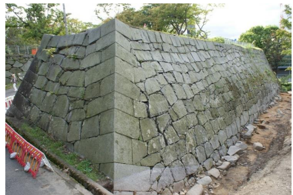
根石押え石（三ノ丸北西部）
