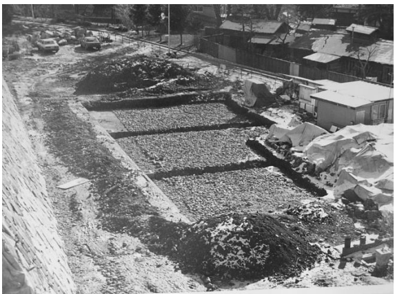
米内蔵基礎地業（淡路丸下南部）
