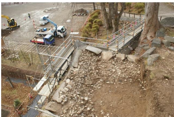
隅石天端付近（三ノ丸南東部）
