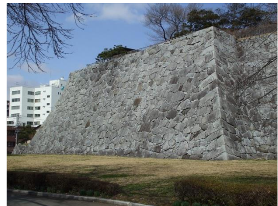
⑥乱積B 淡路丸南西部（修復後）
