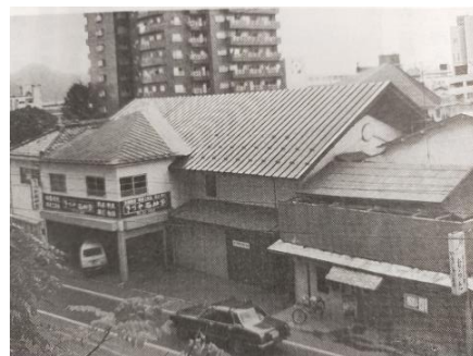
移設前の彦蔵（平成元年）
