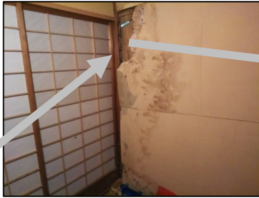
外壁の土壁が崩れ、雨風により内壁も崩落（令和3年8月撮影）
