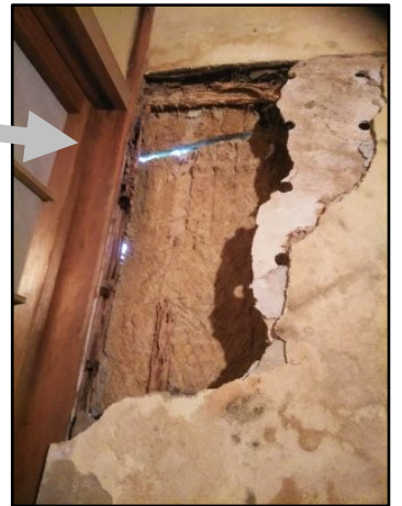
外壁の土壁が崩れ、雨風により内壁も崩落（令和3年8月撮影）
