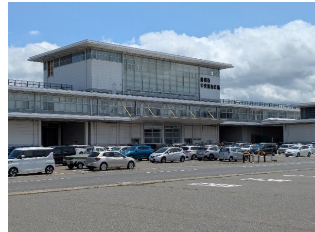
【市場本棟（中央棟）】
