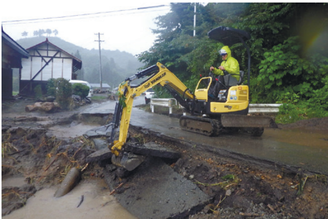
大雨災害により破損した道路の応急復旧 (上米内48号線(上米内野頭))
