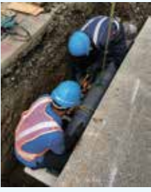
水道管布設工事で新しい管を入れている様子
