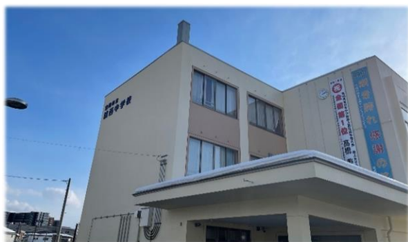
写真 大規模改修後の城西中学校の校舎
