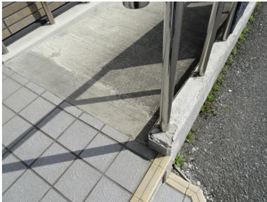
↑ 修繕箇所（遠方から撮影）
