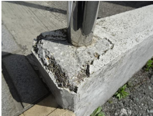
↑ 修繕箇所（近方から撮影）
