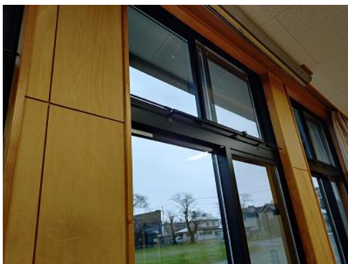
↑ 修繕箇所（ワイヤー）※北側 南側も同様
