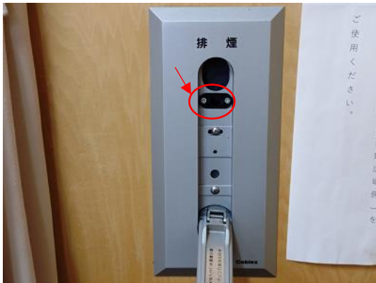
↑ 修繕箇所（新規マグネット取付）
