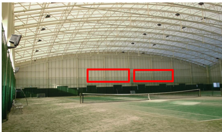
屋内テニスコート北側壁面
