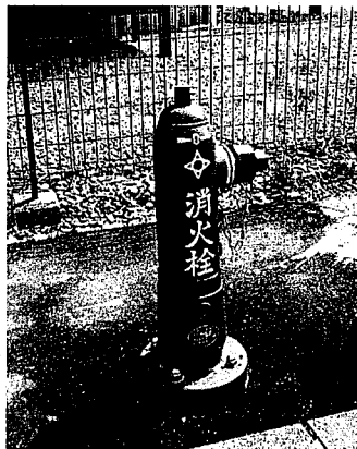
消火栓の塗装 〔手代森〕
