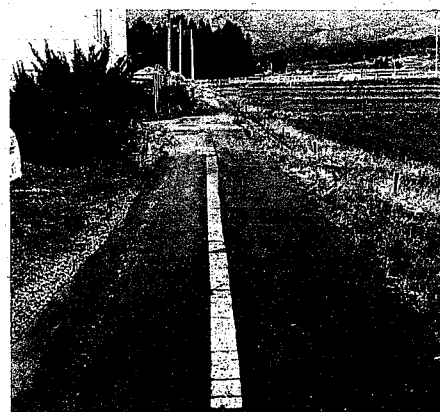
道路補修 〔乙部〕
