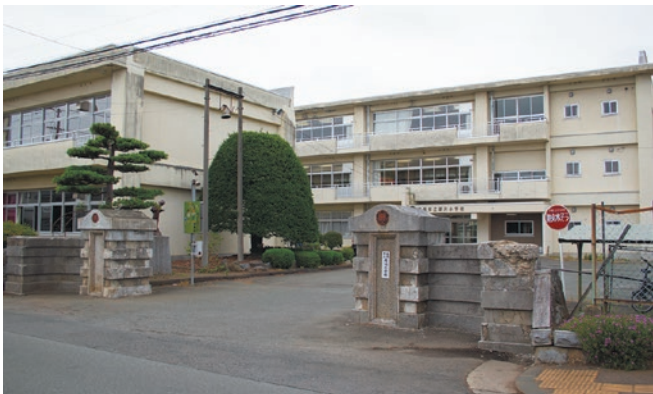
大規模改修が行われる厨川小学校校舎 (厨川児童センターとの複合化を実施)
