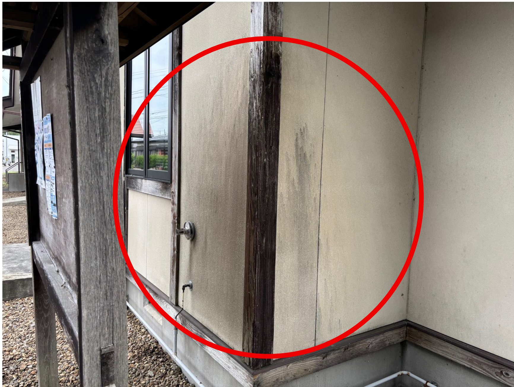
(外壁塗装箇所)
