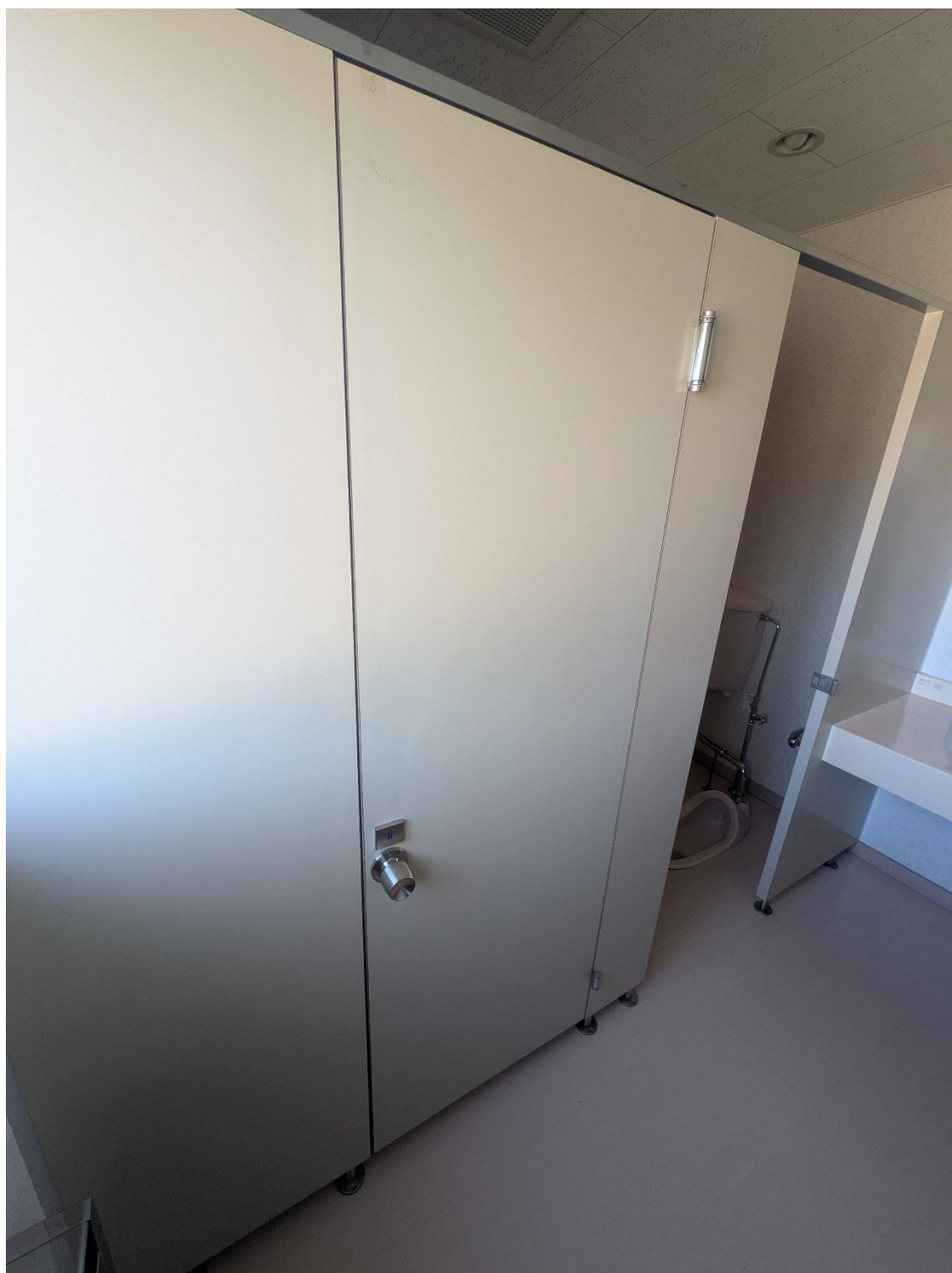
女子トイレ個室ドア施工済（参考）
