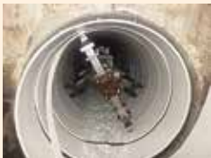
下水道管を内側から新しくする様子
