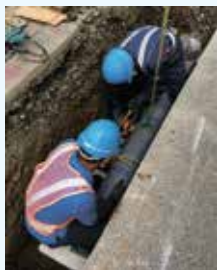
新しい水道管を入れる工事の様子
