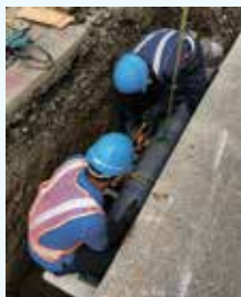
新しい下水道管を入れる工事の様子
