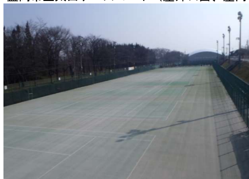
盛岡市立太田テニスコート（屋外14面、屋内2面）
