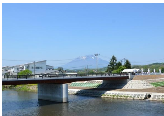
柵沢橋改良事業*
