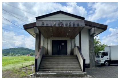
旧玉山歴史民俗資料館 （巻堀字巻堀33-3） ※2025年4月新築移転
