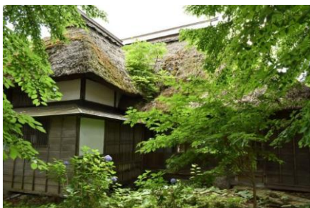
【西側生家茅葺屋根（修繕箇所）】
