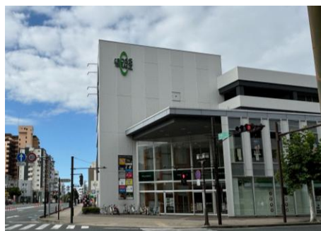
＜クロステラス盛岡入口＞
