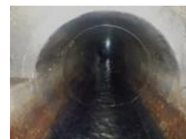
管更生 施工前
