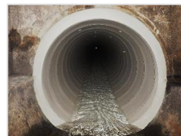
管更生 施工後
