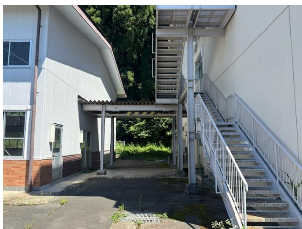
実習場・事務所 渡り廊下
