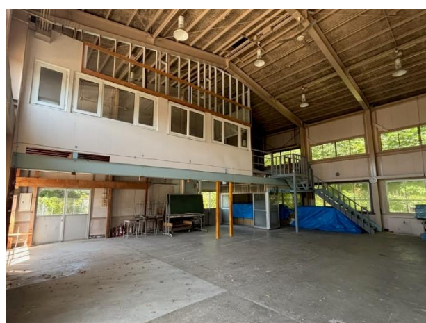
第2実習場内部
