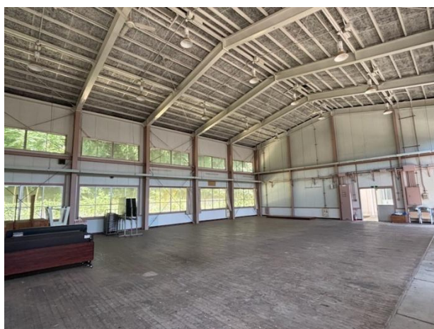
第1実習場内部
