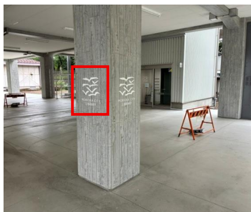
ピロティー柱
