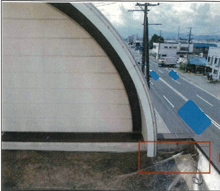
5.2 階防水屋根 より 2 階屋根A 右側
