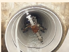
下水道管を新しくする工事の様子
